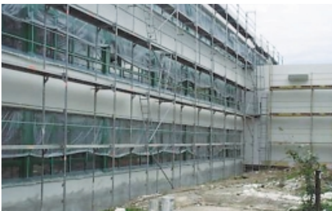
Großbaustelle für eine Klassethele.
